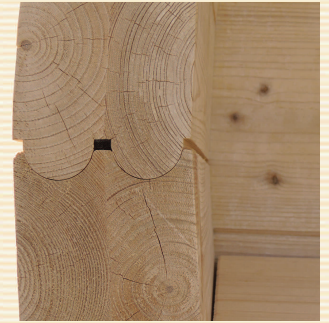
Doppelnut- und Federverbindung
